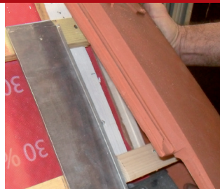
Tuile à bord droit. Mettre une cale sous le rabat au nez pour l'ajuster à la hauteur de la tuile d'aération basse. Prolonger l'emboîtement du rabat à la gouttière par un couloir. Rogner le dessous de la baguette d'emboîtement de la tuile d'aération basse pour que celle-ci s'emboîte parfaitement.
