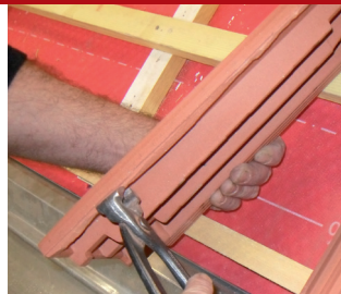
Tuile à bord droit. Mettre une cale sous le rabat au nez pour l'ajuster à la hauteur de la tuile d'aération basse. Prolonger l'emboîtement du rabat à la gouttière par un couloir. Rogner le dessous de la baguette d'emboîtement de la tuile d'aération basse pour que celle-ci s'emboîte parfaitement.
